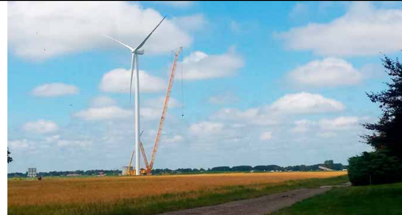
De eerste windmolen wordt gebouwd (foto: Pondera Consult)
